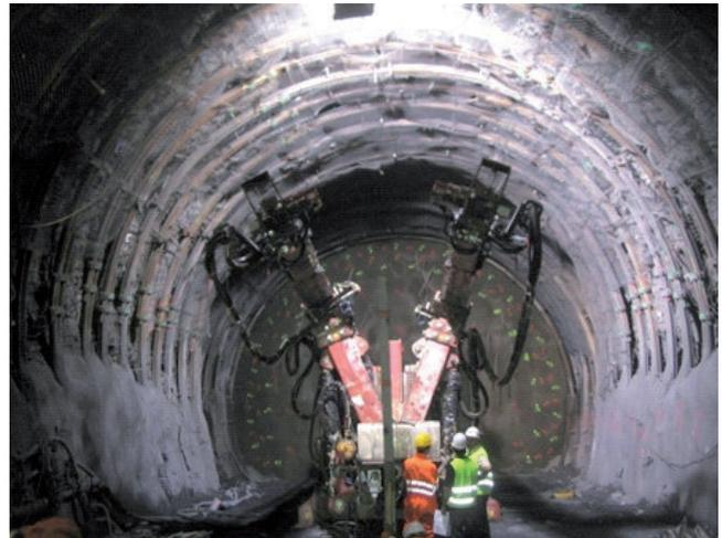
Photo 8 - Consolidation du massif en avant du front
