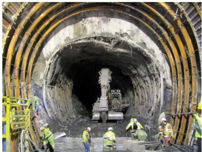
Photo 6 - Réalisation de l'anneau béton avec un coffrage perdu, après réalésage de la section
