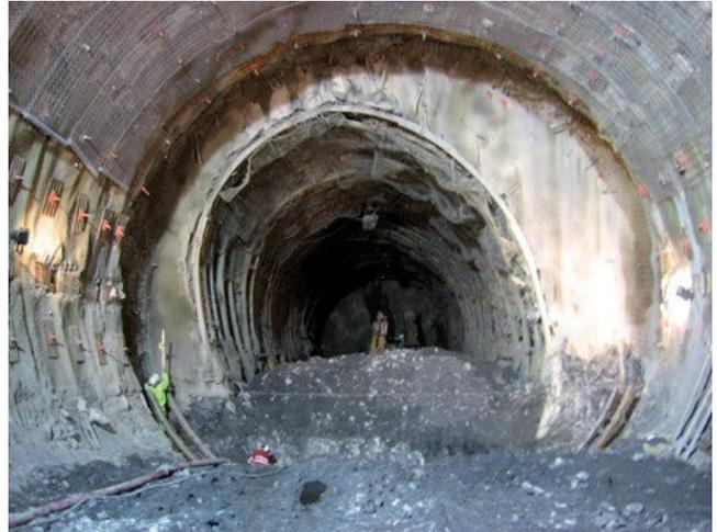
Photo 5 - Déformation de la section
