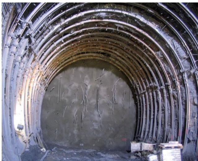
Photo 4 - Profil de soutènement souple de type 1
