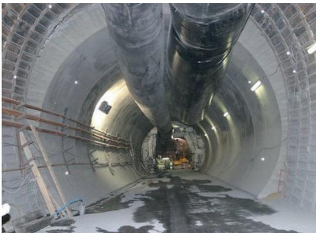
Photo 7 - Modification de la géométrie de la section (ancienne et nouvelle section)
