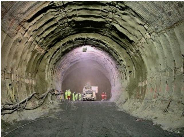
Photo 10 - Soutènement intermédiaire semi-rigide
