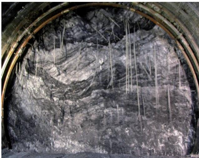
Photo 3 - Front de taille dans les schistes charbonneux du Houiller productif
