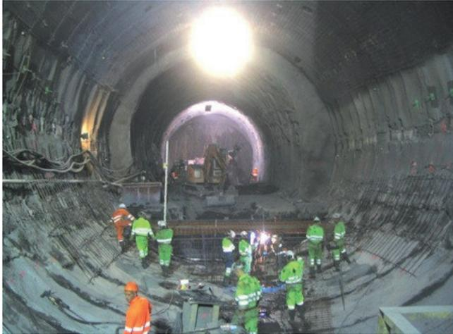
Photo 9 - Soutènement intermédiaire semi-rigide
