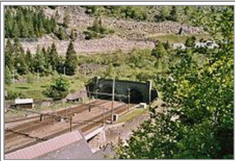
L'entrata nord del tunnel del San Gottardo a Göschenen
